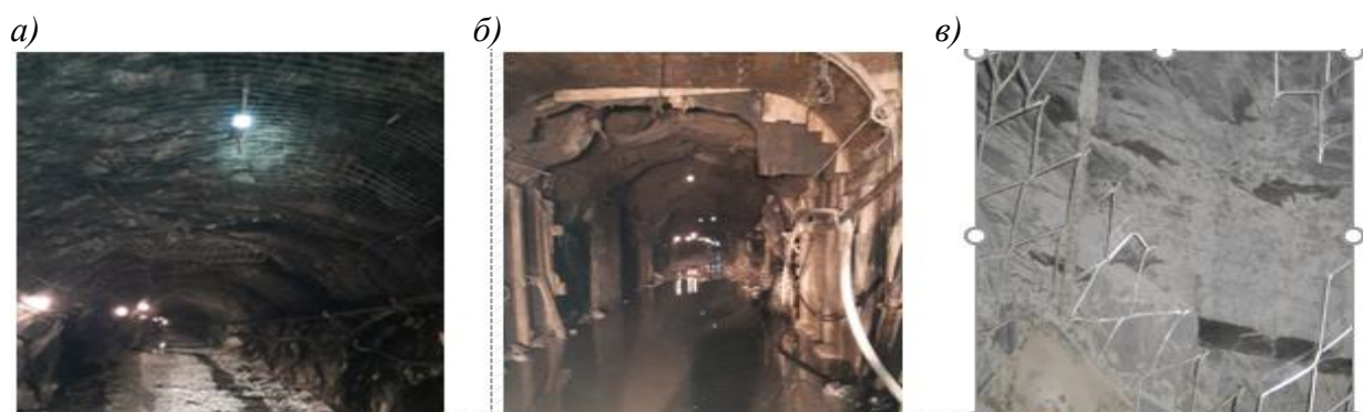
Рисунок 3.5 – Репера со светящимися марками ( а, б ), в - состояние потолочины 4-орта рудника ТОО «Nova –Цинк»
